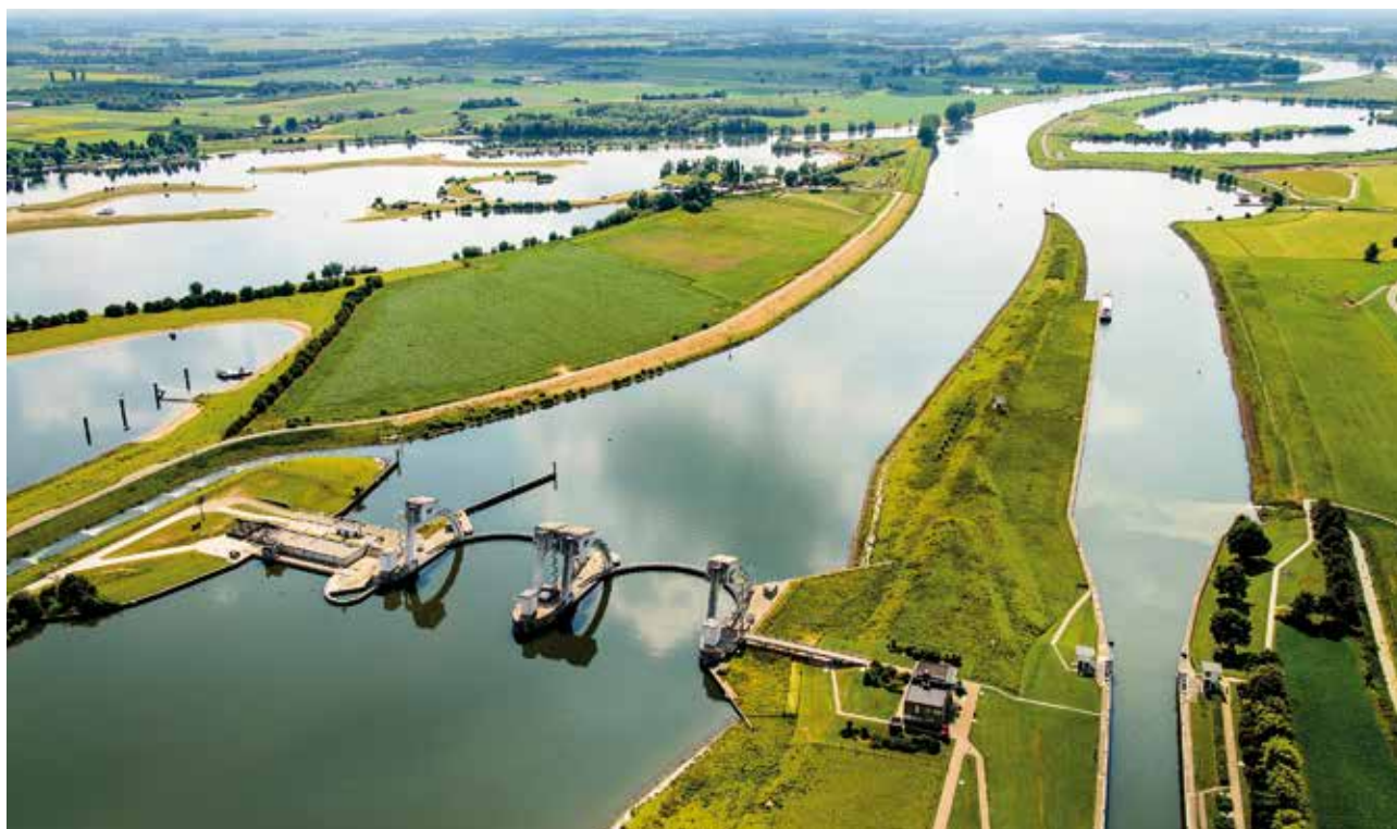
➔ Sluis- en Stuwcomplex Amerongen in de Nederrijn. Naast de stuw bevinden zich een schutsluis en vispassage.
